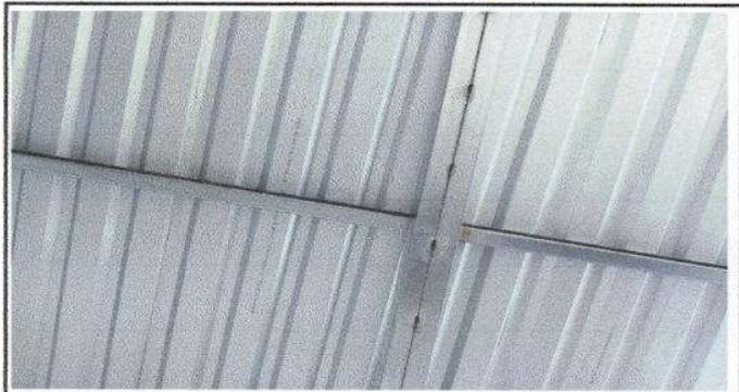
Foto 8: Sustitucion de lamina aluzinc calibre 26 aulas 3 y 4
