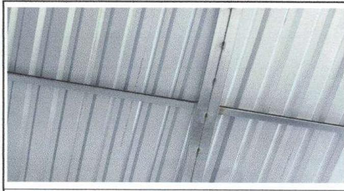
Foto 4: Sustitucion de estructura de madera por metal en aulas 3 y 4
